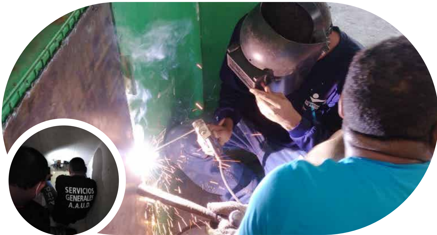
Instalación de láminas lisa en el P.H. Multiplaza
